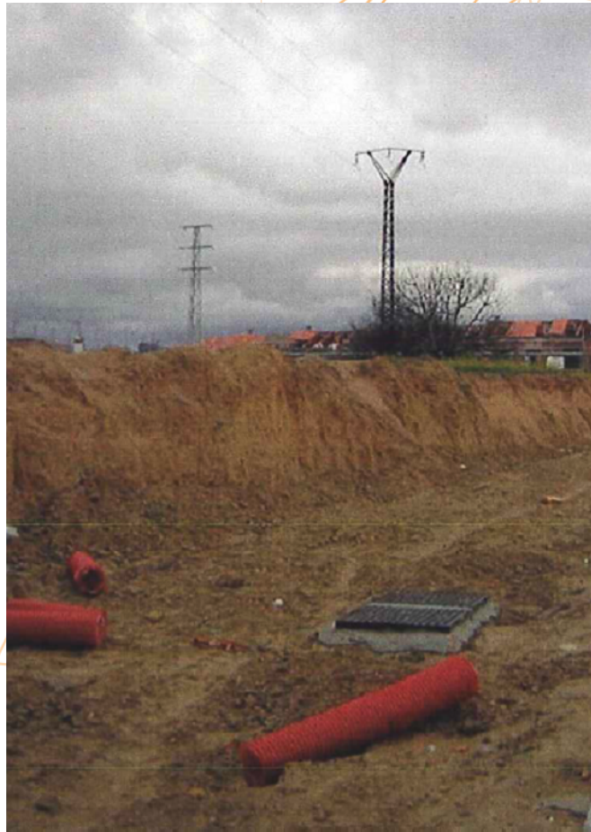
Imagen 5. Obra civil para el soterramiento de la línea eléctrica de alta tensión
